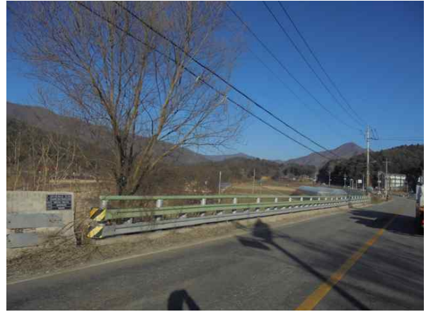
난간 및 연석 전경
